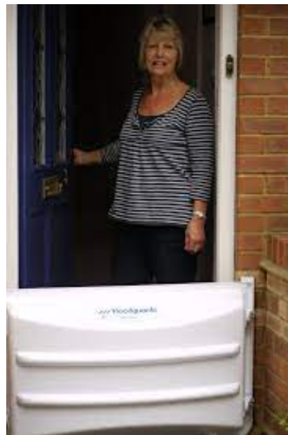
Figura 14; Barrierë përmbytjeje për derën
