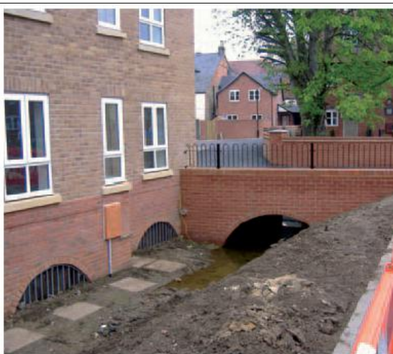
Fig 9 Mbrojtje nga përmytjet me mur kufitar dhe kullues
