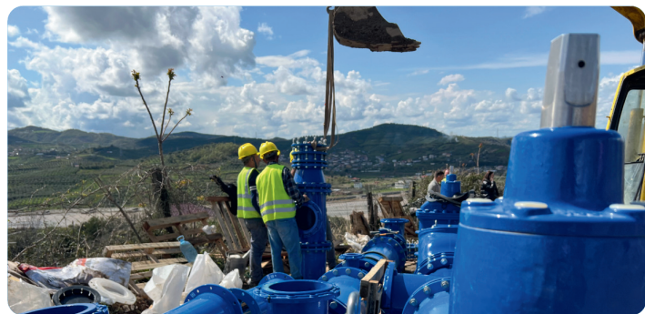
Tubacione të reja kryesore të shpërndarjes janë instaluar.
