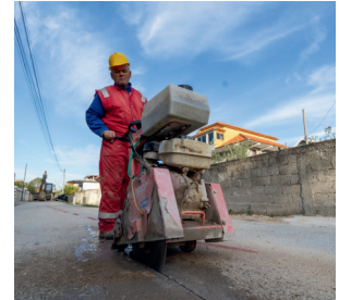
Prerja e asfaltit për përgatitjen e instalimit të rrjetit.
