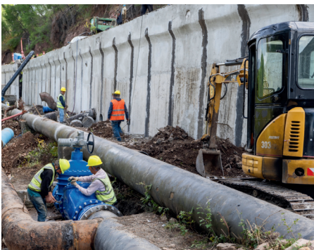
Ndërtimi i rezervuarit të ri të ujit në Krastë e Madhe, i cili do të mbajë 2,000 m 3 ujë të freskët dhe të pastër të pijshëm.
