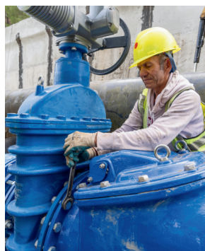
Punimet për instalimin e një pompe të re për rezervuarin e rehabilituar të Krastës së Madhe.
