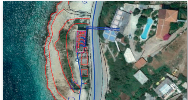
Pamje nga sipër e Stacionit të Pompimit 6 - Rehabilitimi i digës mbrojtëse nga uji i detit
